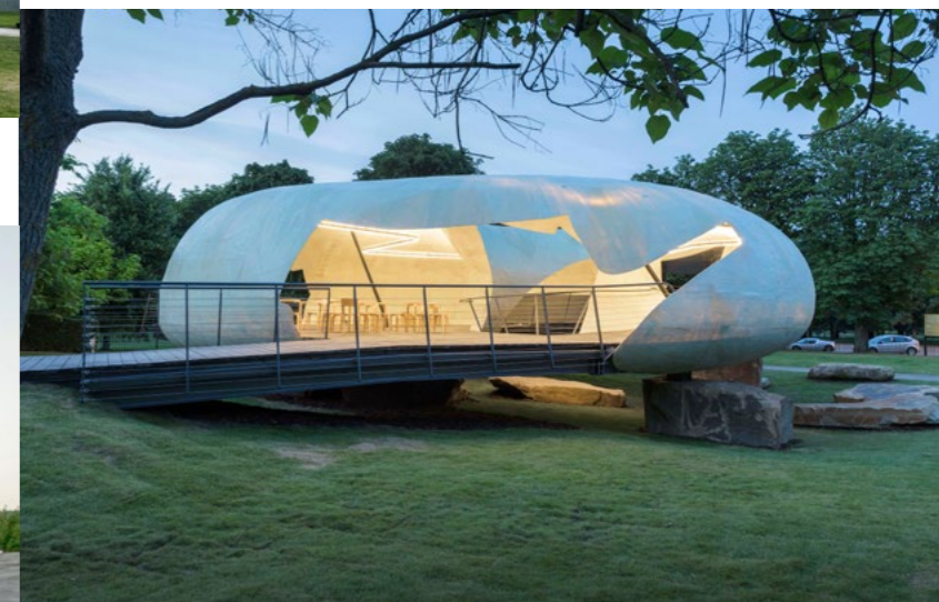
Serpentine Gallery Pavilion w Londynie – przezroczysta powłoka z włókna szklanego wydaje się unosić nad trawnikiem
