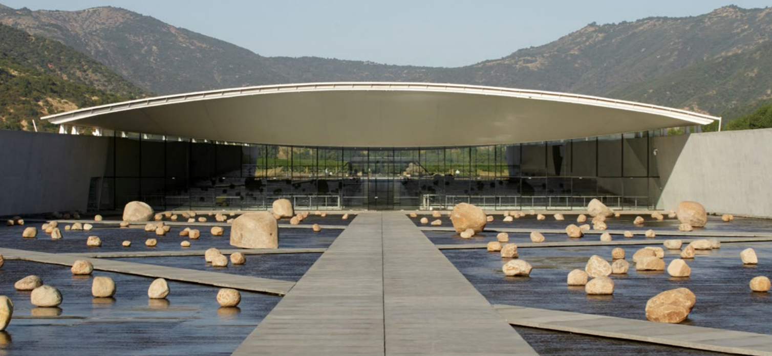
Winnica VIK w Millahue – w tym projekcie lustro wody obniża temperaturę beczek bez użycia energii
